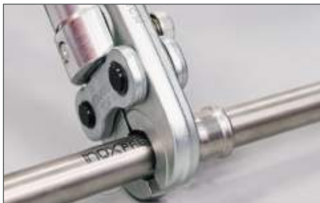
Assemblaggio attraverso pressatura / Making the press connection
